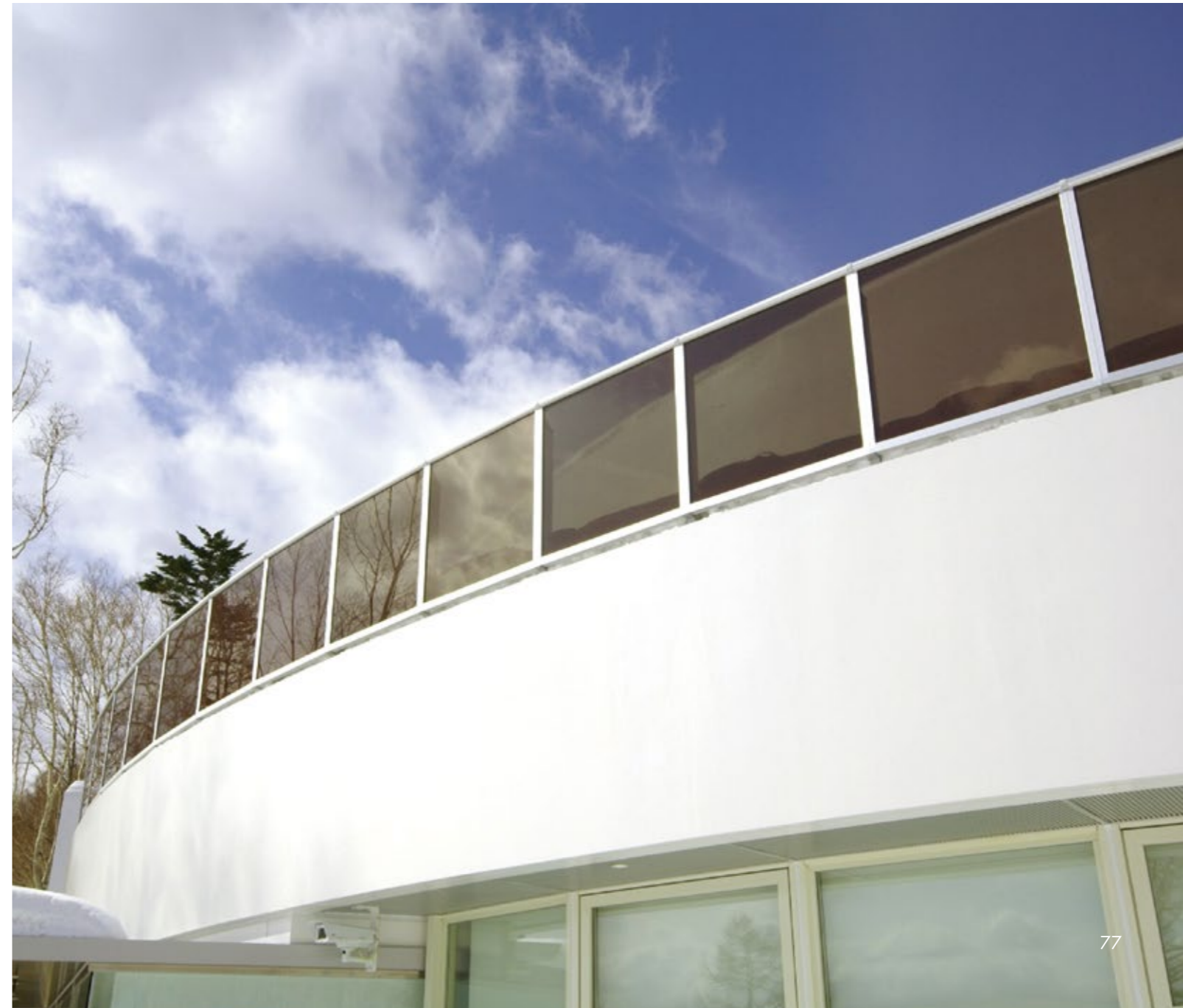
完成 (ガラスシール及び支柱足元左官仕上未済)
