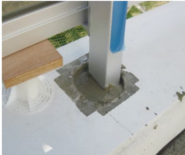
9. グラウト注入/コン天際 充填
